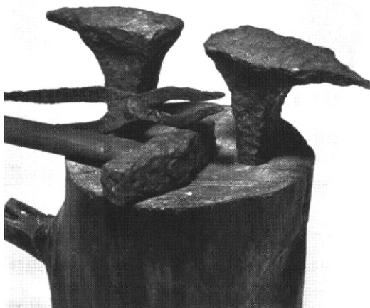
Bild 3. Städ, hammare och tång var de främsta smedverktygen.
