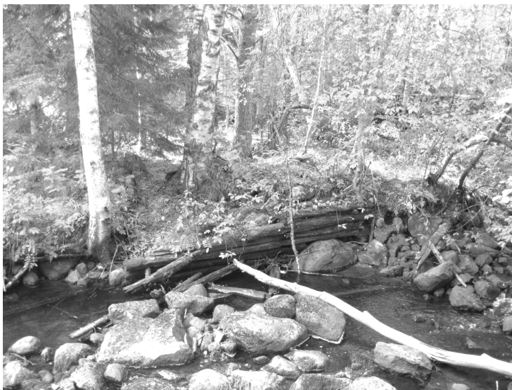
Illustration 2. Gunnisfors sågverk existerade endast i åtta år mellan 1885 och 1893. I den sidofåra av Sävarån där det låg syns ännu tydligt timmerförstärkningen på den plats där vattenhjulet var beläget. Den är registrerad på fornminneskartan som en kulturhistorik lämning < www.fmis.raa.se/cocoon/fornsok/search.html >. Foto: Robert Eckeryd 2014.
