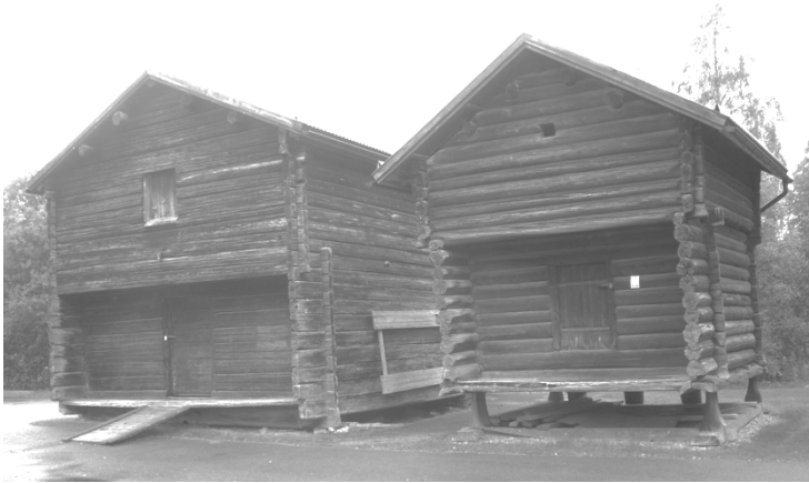
Bild 1. Vid Överhogdals kyrka står två vältimrade byggnader, dels ett stort magasin uppfört 1824, dels ett härbre från 1751 uppfört av rundtimmer. Inuti det senare hittade Paul Jonze 1910 Överhogdalsbonden. Foto: Erik J. Bergström 2017.
