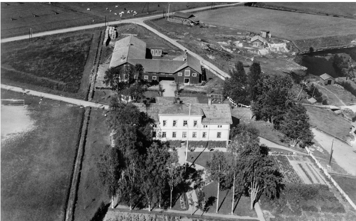
Bild 4. Flygfoto från mitten av 1930-talet över Stenfors herrgård med ekonomibyggnader.
